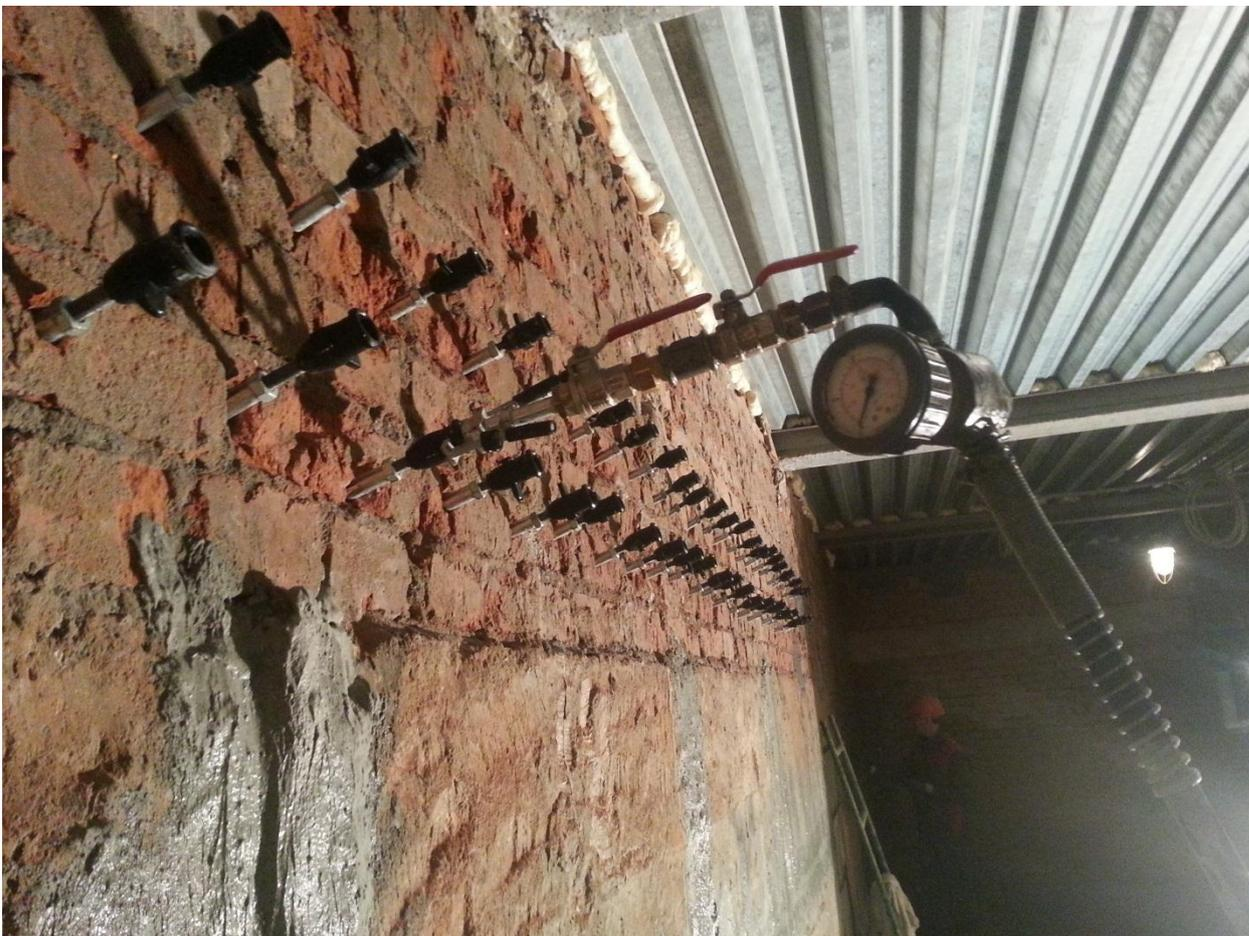
Работы проводятся методом инъектирования с использованием следующего оборудования:
